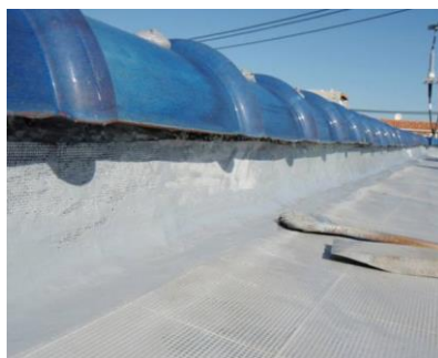
補強布の張付け
