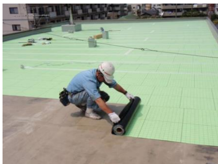
自着タイプ通気緩衝シートの張付け
