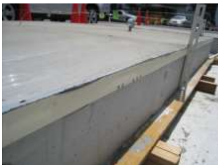
写真 3.2.10 ウレタン防水層通気緩衝工法試験体の側面納まり
