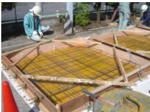
写真 3.2.1 試験体型枠
