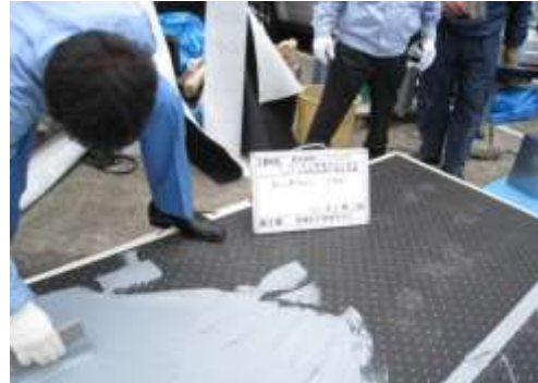
写真 3.2.8 通気緩衝シートの施工
