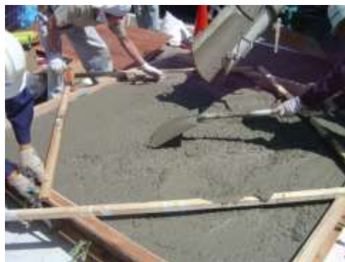
写真 3.2.2 コンクリート打設
