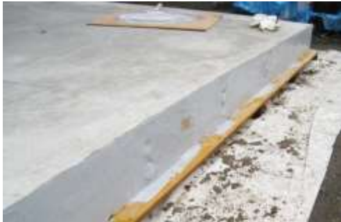
写真 3.2.7 側面エポキシ樹脂コーティング
