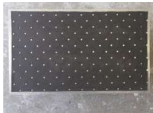
写真 3.3.3 通気緩衝シート張り付け
