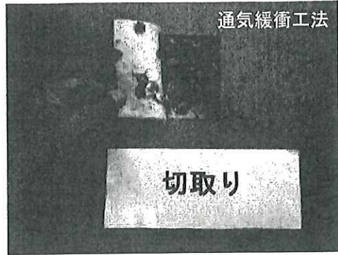
写真6 通気緩衝工法切り取り
